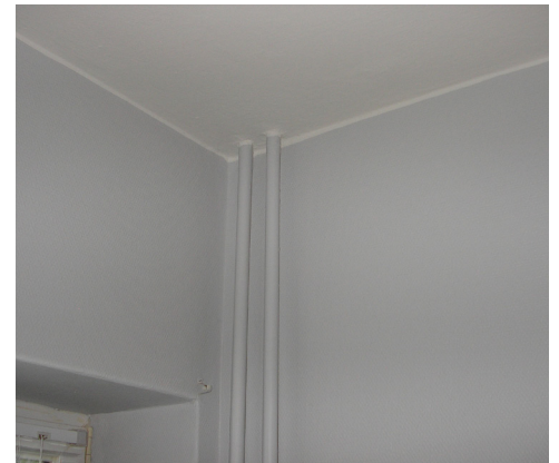
Eksisterende stigestrenge (vandrør)
